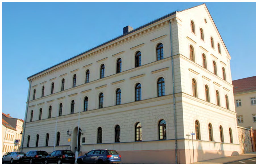
Amtsgericht mit denkmalgeschützter, sanierter Fassade
